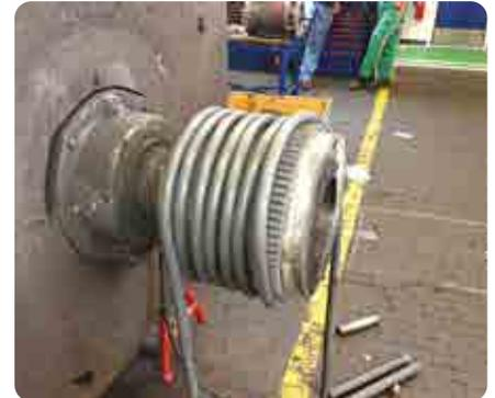
**Erwärmung einer Kupplung zur Demontage**
